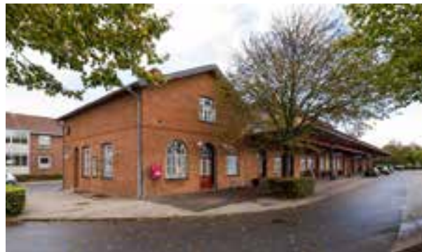
Bramminge station er en af de stationer, der er blevet udviklet i løbet af de seneste år. Her er løsningen blevet et samarbejde mellem Esbjerg Kommune, Kirkens Korshær, Bramminge Lokalråd og DSB Ejendomme. Esbjerg kommune har lejet stationen af DSB Ejendomme og vil sammen med lokalrådet løbende se på, hvordan man kan få flere aktiviteter ind i den hyggelige stationsbygning.
