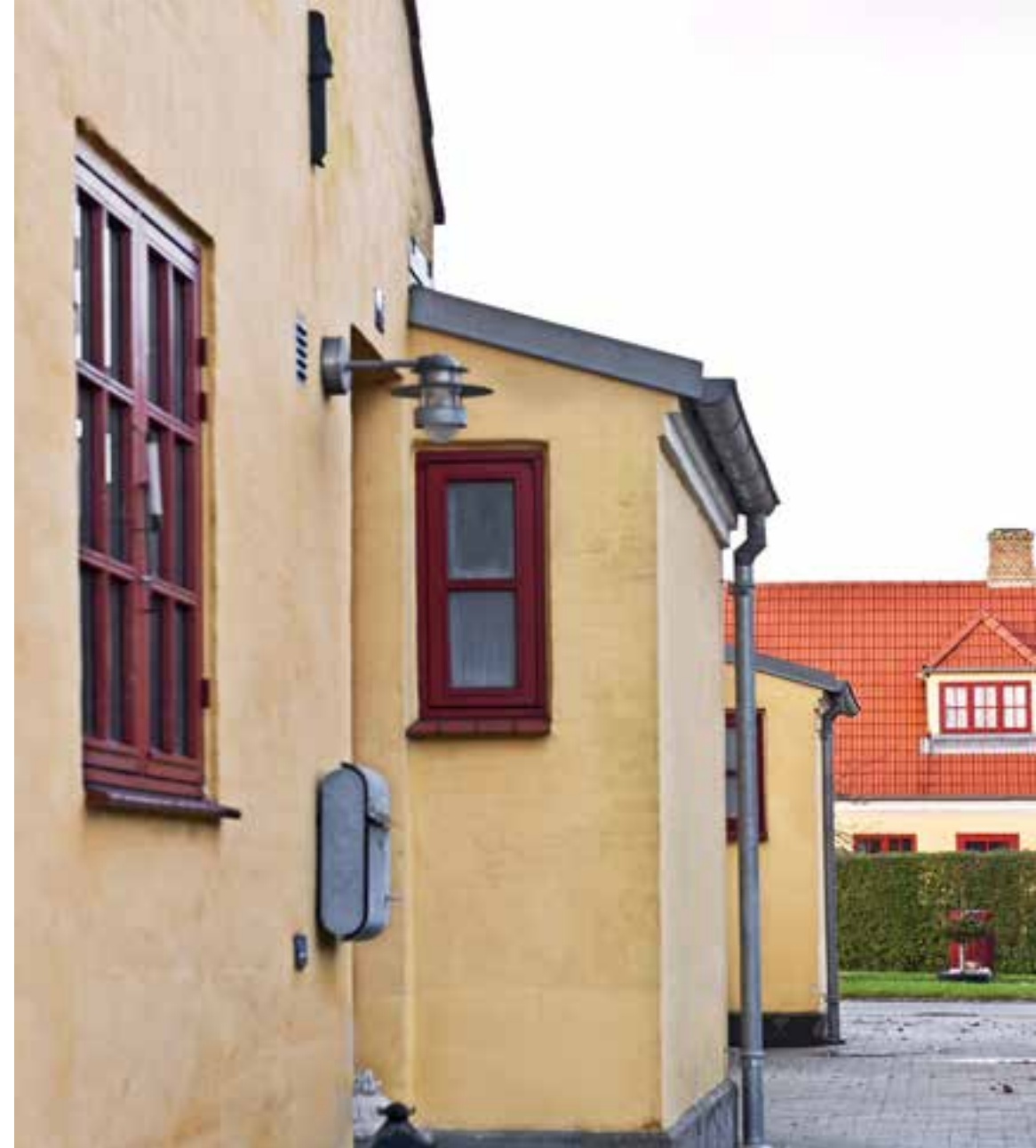
En af de ejendomme, som DSB har til salg er de små gule rækkehuse i Valby "Den Gule By". Boligerne blev bygget til medarbejderne på "hjælpevognen" i DSB, som var en beredskabsvogn, der rykkede ud i forbindelse med afsporinger eller ulykker. Medarbejderne havde bopælspligt på Otto Busses Vej for hurtigt at kunne rykke ud. Bopælspligten er i dag afløst af et krav om at kunne møde på arbejde inden for 20 minutter. "Den gule by" består af 31 mindre rækkehuse og 2 større mesterboliger med tilhørende have. I alt 33 boligheder på 86-125 kvm. Københavns Kommune har givet principal tilladelse til udstykning i 33 enheder. Salget gennemføres af RED Property Advisers for DSB Ejendomme og udbudsprisen for de 3.320 kvm. er 85 millioner kr.
